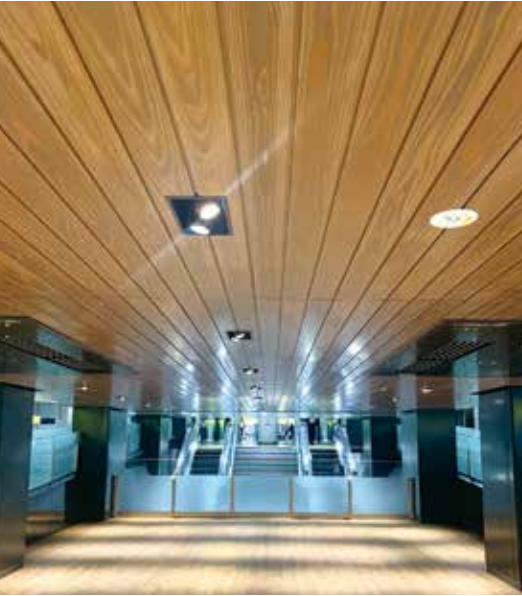
地下鉄銀座駅の自由通路天井
