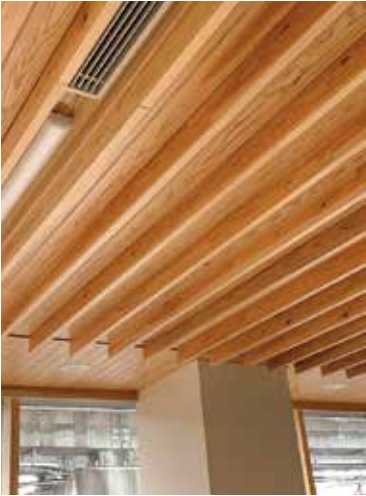
某公共施設の天井ルーバー
