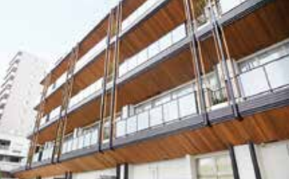
軒天にサーモウッドを使用
