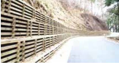
「高耐久木製柵」を使用した土留工
