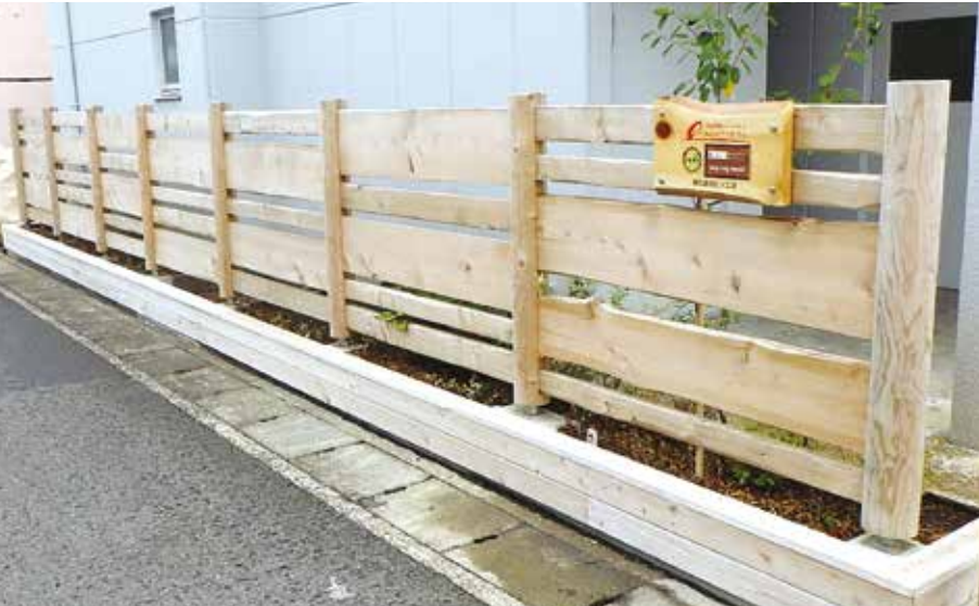
削孔支柱ピン工法による木堀
