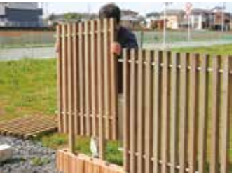
新設のコンクリートブロックに立てる
