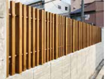
既設のブロック塀や基礎に立てる
