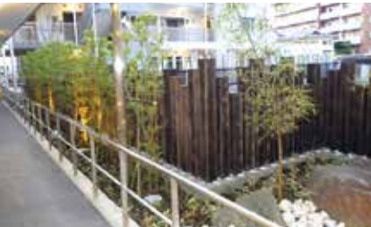
削孔支柱ピン工法による木柵
