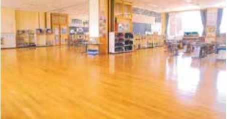
東京の木 多摩産材スギ心材フローリングの施工例
