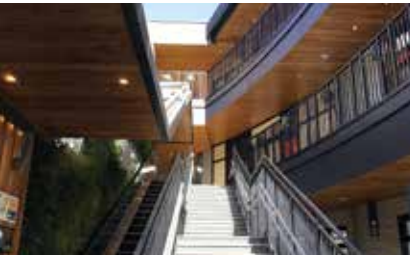
某商業施設の軒天
