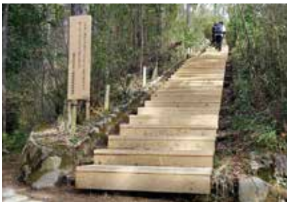
公園緑地を整備する木道・階段
