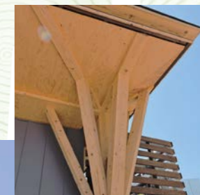
木の幹に見立てた庇の柱 無垢材を使用し、一部の箇所は 鉄骨を木で覆っている
