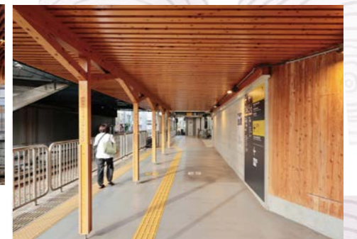
ホーム通路 天井と連続する柱が古い駅舎を彷彿させる（旗の台駅）
