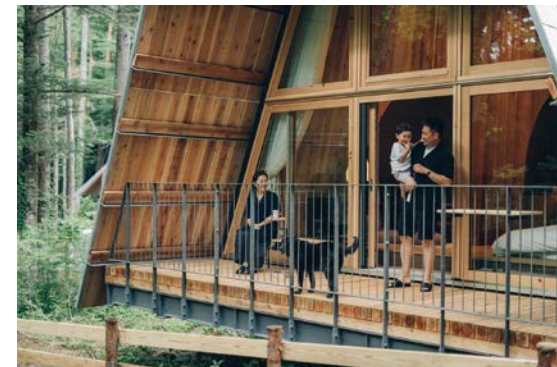
SANU CABIN シリーズ (写真左・中央) 立地環境に応じて複数のタイプがあり、いずれも工程の大部分が工場で施工されるので、自然環境下でも負荷が少なく施工もより安全になる
